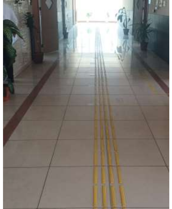
Şekil 12 Engelli Yürüyüş Yolu
