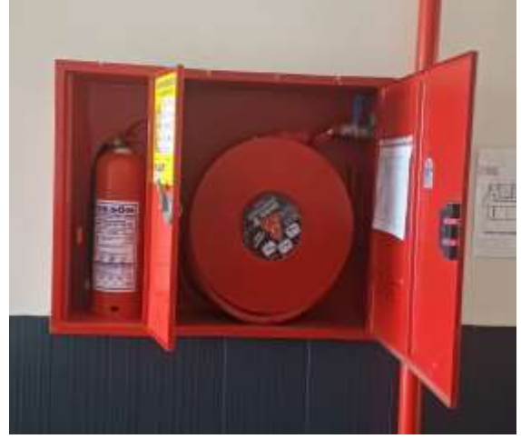
Şekil 1 Yangın Dolabı
